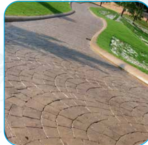
Bê tông giả đá 02
